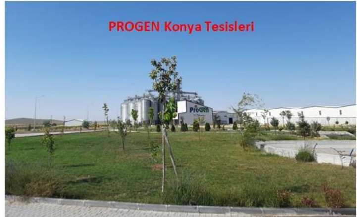
PROGEN Konya Tesisleri
